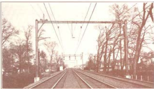
D. L. & W. R. R. Electrification—Catenary Construction
